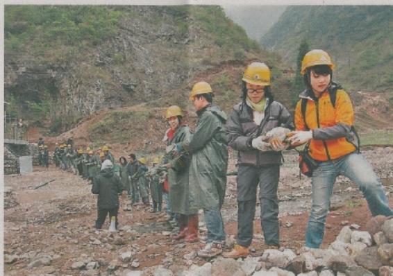
■志願者在雲南昭通市昭陽區放馬壩村合力築橋，以方便貧困山村村民過路。(受訪者提供)
