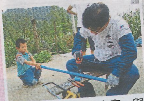
重慶星光村當地小童，與無止橋義工一同施工。
